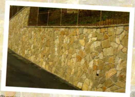
Rivestimento muro con beole fini 3-6
