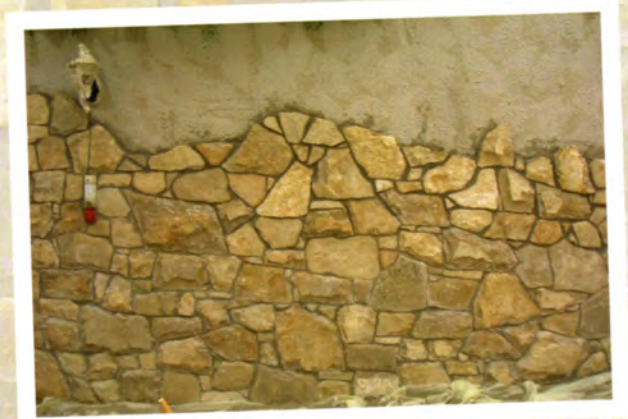
Rivestimento muro con beole fini 3-6 in fase di realizzazione
