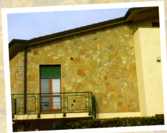
Rivestimento muro casa
