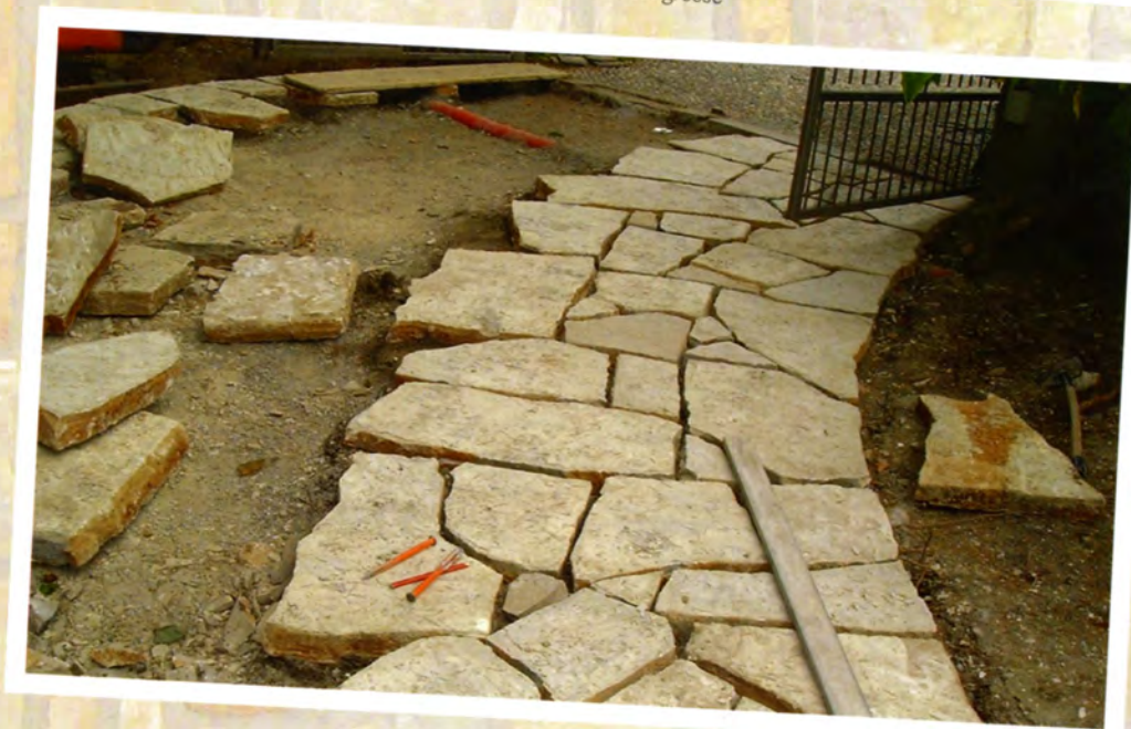
Pavimento con beole grosse in fase di realizzazione
